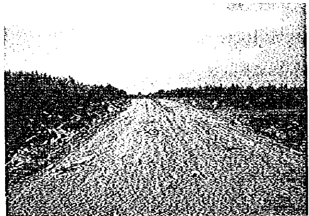
搬入道路状況
