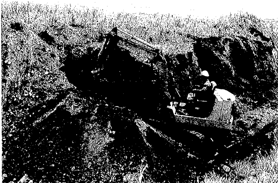
バックホーによるトレンチ掘削
