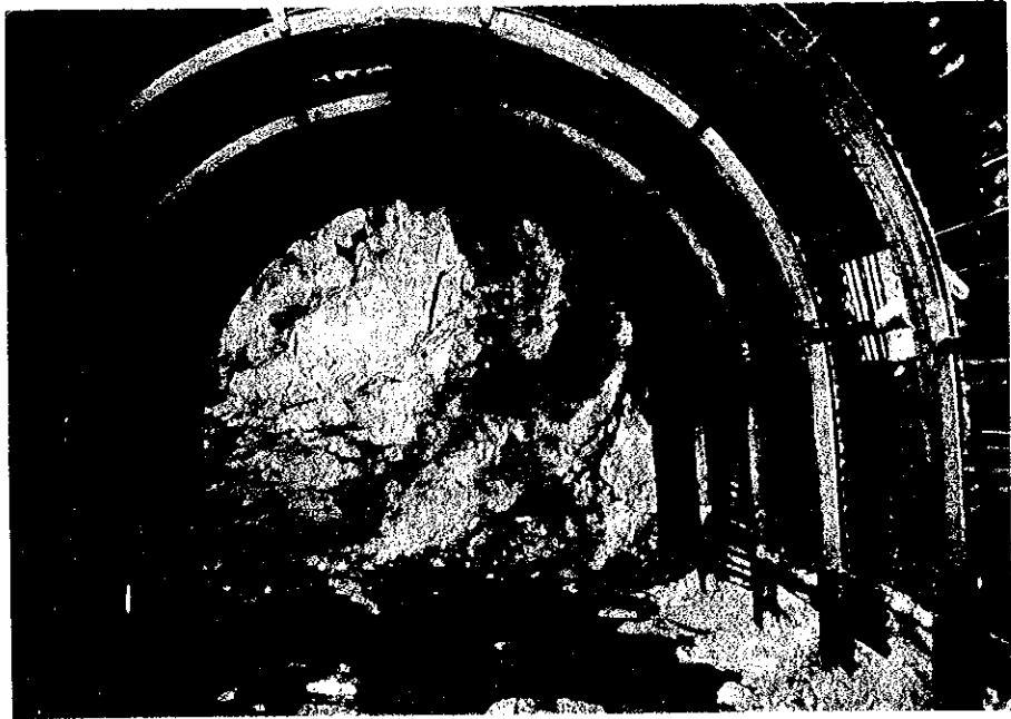
立入坑道引立部
