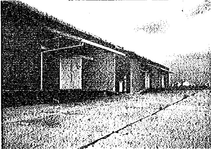
写真-8 日本の援助で建設されたカロモの倉庫。ひとつはZCFが借用している。 (カロモ県、南部州)
