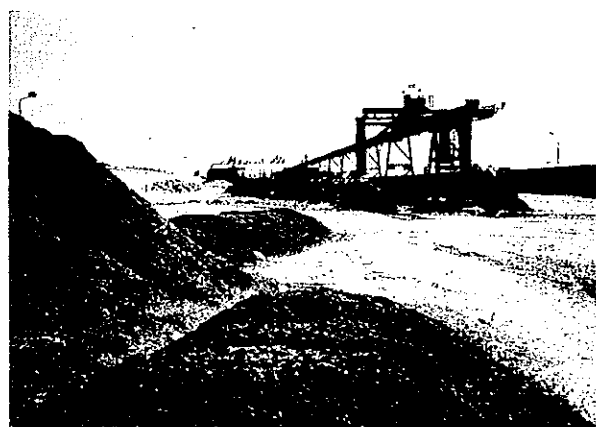
発酵・養生ヤード
