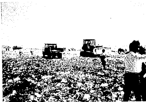
アビス最終処分場運営用ブルドーザー
