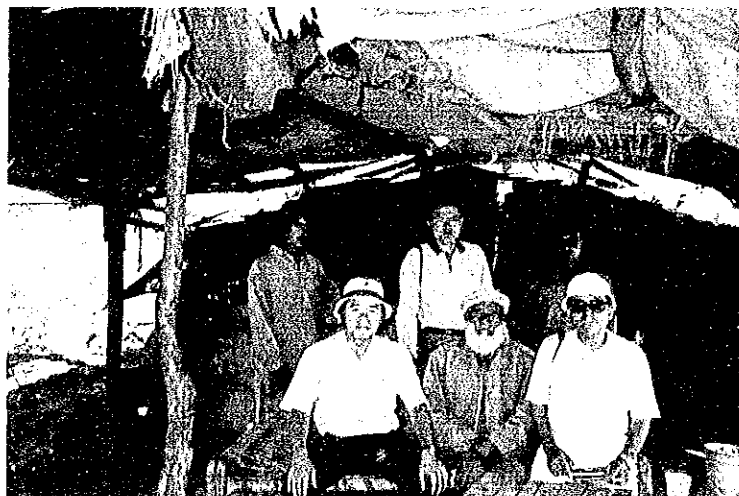
イスラマバート郊外住宅建設現場の飯場コーヒーショップ
