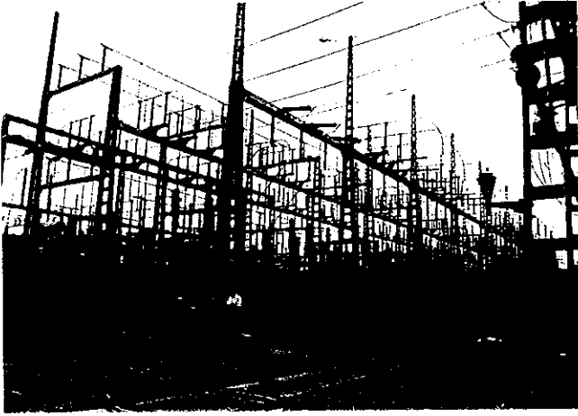
写真-4 コロンナワ変電所 屋外機器
