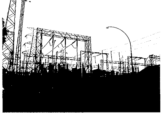
写真-11 ケラニティッサ火力発電所 屋外機器
