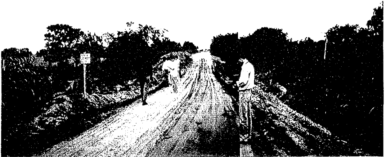
コルゲートパイプがある部分は道幅がせまく、くぼんでいる。
