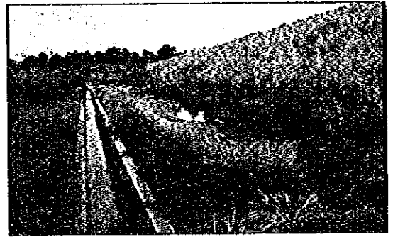
Projet d'Irrigation d'Adahou : Barrage et Canal Principal d'Irrigation
