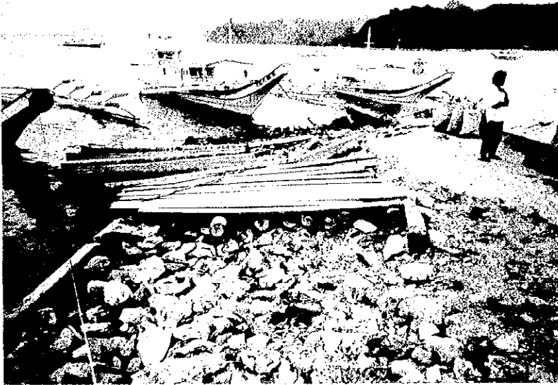
エルニドの港湾施設の現況 (先端部分の破損)
