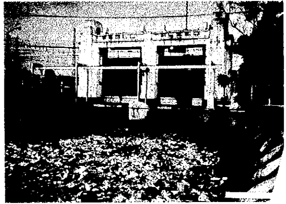
㉠ 西バンジール放水路 マンガライ堰付近 (流れてきたゴミが滞積している)
