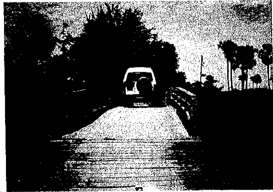
プリベーンへ向う現道 (3)
