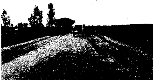
国道1号線 (ADBによる緊急補修済区間)
