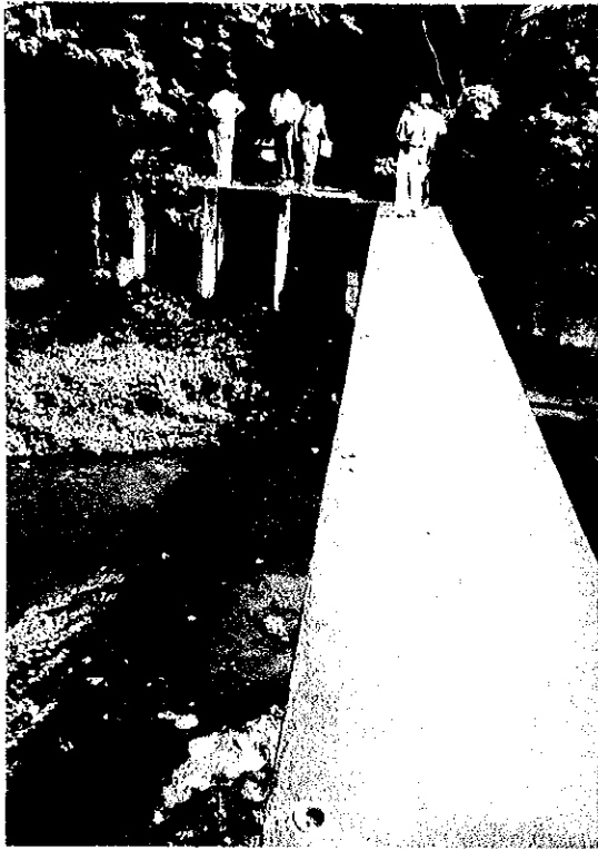
①地点：Igban川に建設されている既存頭首工 取水口は完成しているが、水位を 上げるための構造物は建設されていない。
