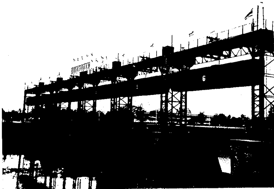
▶ チャイナート・バサック 用水路 (第8地方事務所前)
