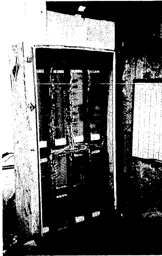
屋外キャビネット設備 (Colombo)
