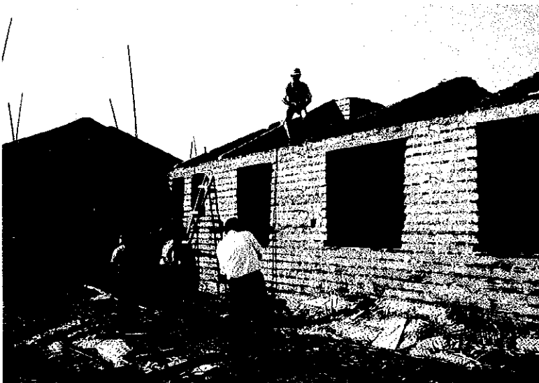
建設中の職員宿舎 (国立植物検疫所 敷地内)
