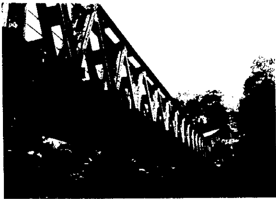
㉔主構に補強した形跡があるが主構が中央でたわんでいる。(33 12/3)
