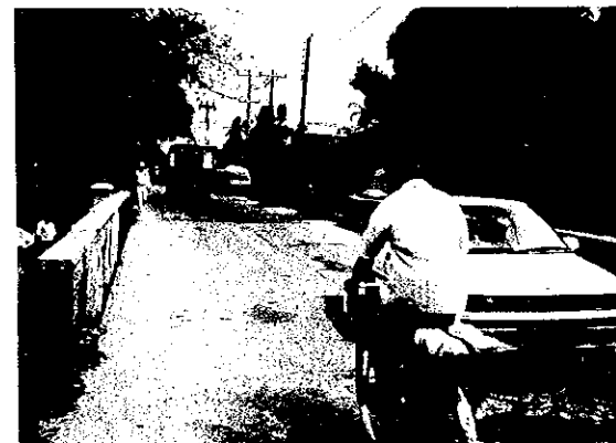
⑪市街地にある2車線橋架、交通量は多い (23 5/3)
