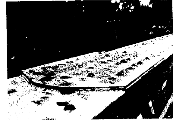
⑭スプライスのリベット頭部が腐食している。 (23 5/3)
