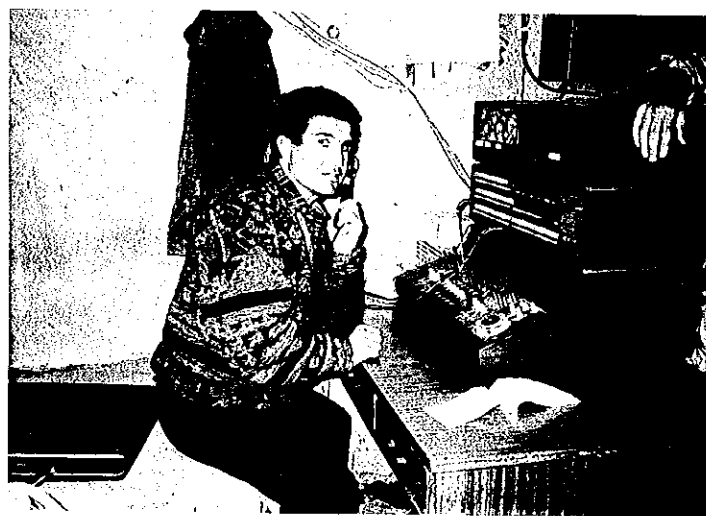
ルーラル地域の電話局で稼働中のマニュアル交換機とオペレータ
