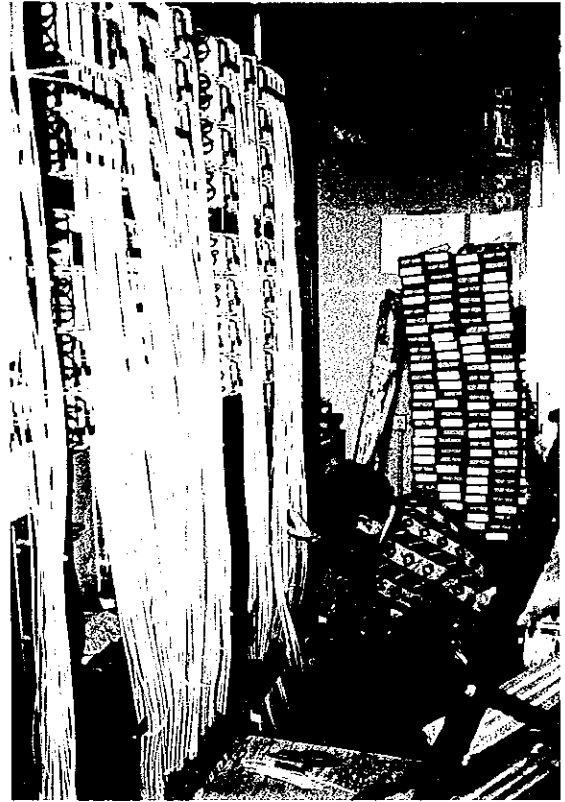
ドイツシーメンス社製交換機の設置作業 (ダマスカス市内)
