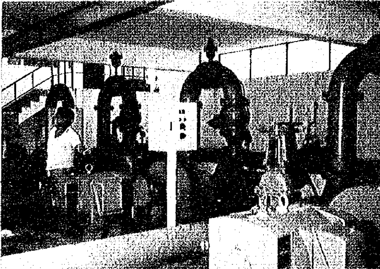
ペントネージャ市 ポンプステーションPW-5内部
