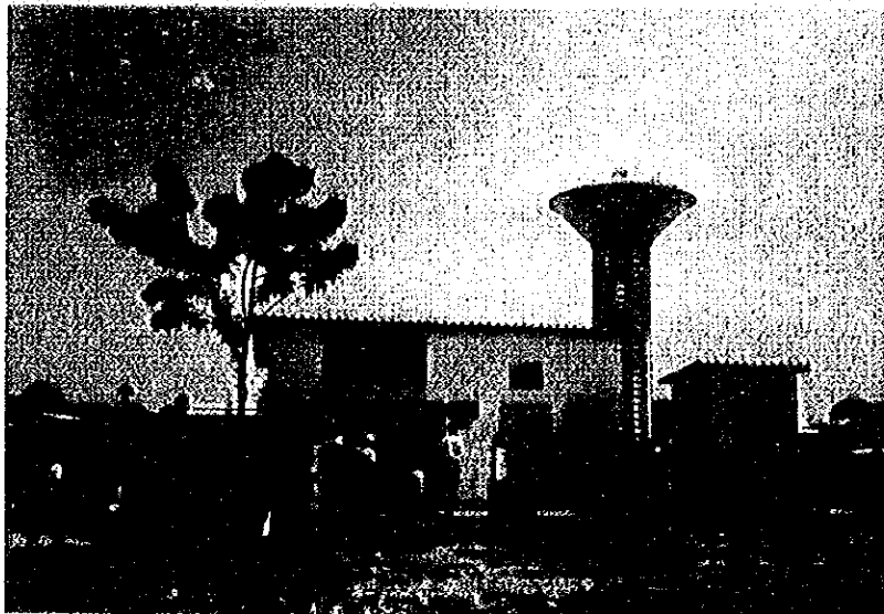
ポンプ室と高架貯水タンク の存在。
