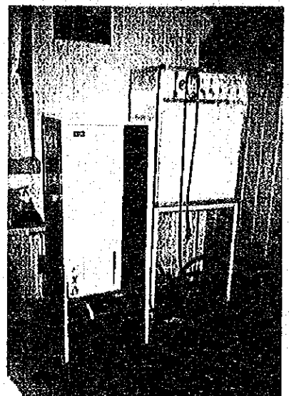
右はRO水（逆浸透水）製造装置：RO膜が機能していないため、使用していない 左は純水器：故障中でスペアパーツ無し
