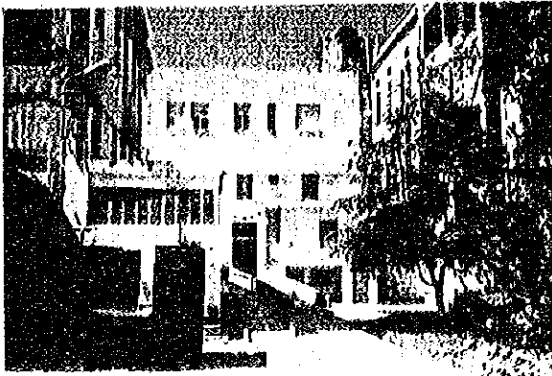
サンロケ病院・消化器病診断・研究センター外観：3階部分がセンターとなっている
