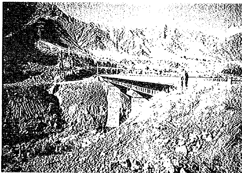
写真-17 現道に架かる橋。戦車の80ト ン荷重で設計されている。 この区間の日交通量は3,000台。
