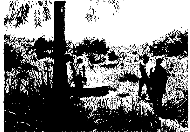
6 Mubende県、Kapoma Valley Tank。井戸のむこうには、ため池があり、井戸との間は暗渠で通じている。約1,500人が使用している。
