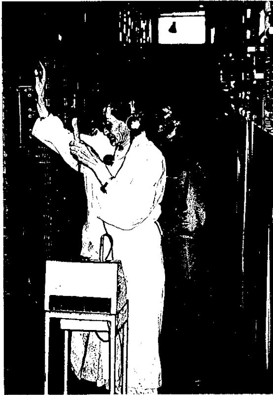
中央局 S X S 交換機の障害調整
