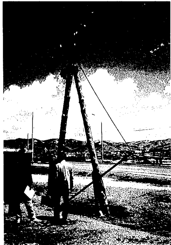
地下ケーブルから架空への立上げ状態 (ゲル地区)
