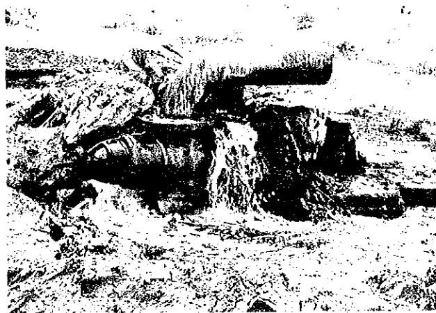
▲ ヒスパンH-2近影 (汽水の自噴井) 湧水量は1984年6月556 l/s。老朽化のため漏水が 激しい。
