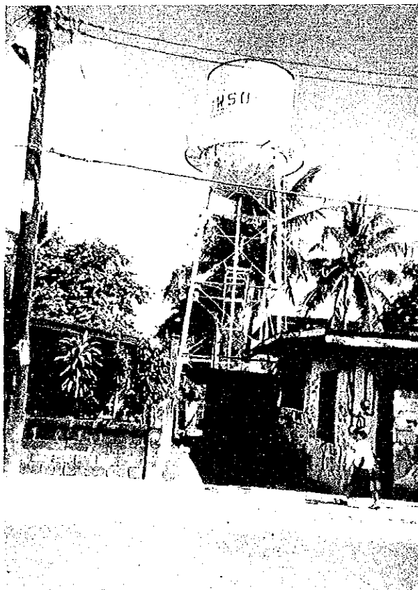
レベルⅡ給水施設である高架水槽 (地方で人口が比較的密集した地域で使用されている。)
