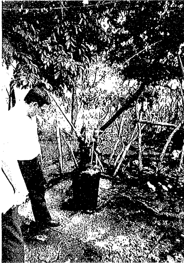
レベルI 給水施設として建設された浅井戸と ハンドポンプ
