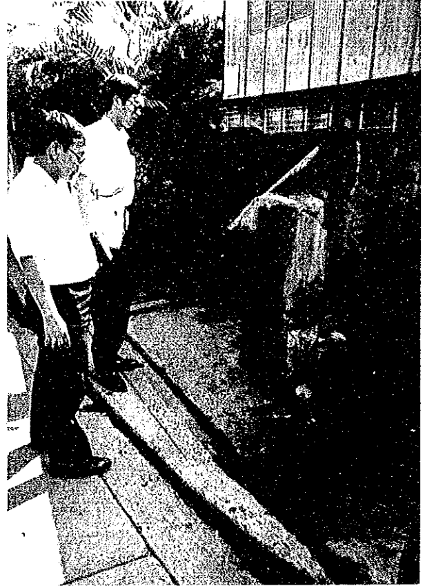
レベルI 給水施設として建設された深井戸 (衛生面を考慮して排水構が施されている。)
