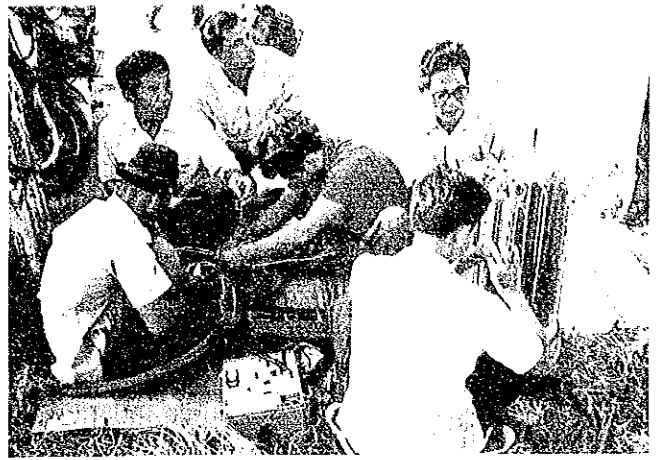
▲ 障害ケーブルの復旧作業 (補修部品・材料がないため、障害発生後数年間放置されていたもの)
