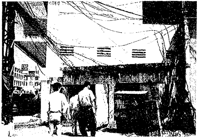
▲ 加入者線及びキャビネット (地下ケーブル障害のため架空線により非正常な工法がとられている)
