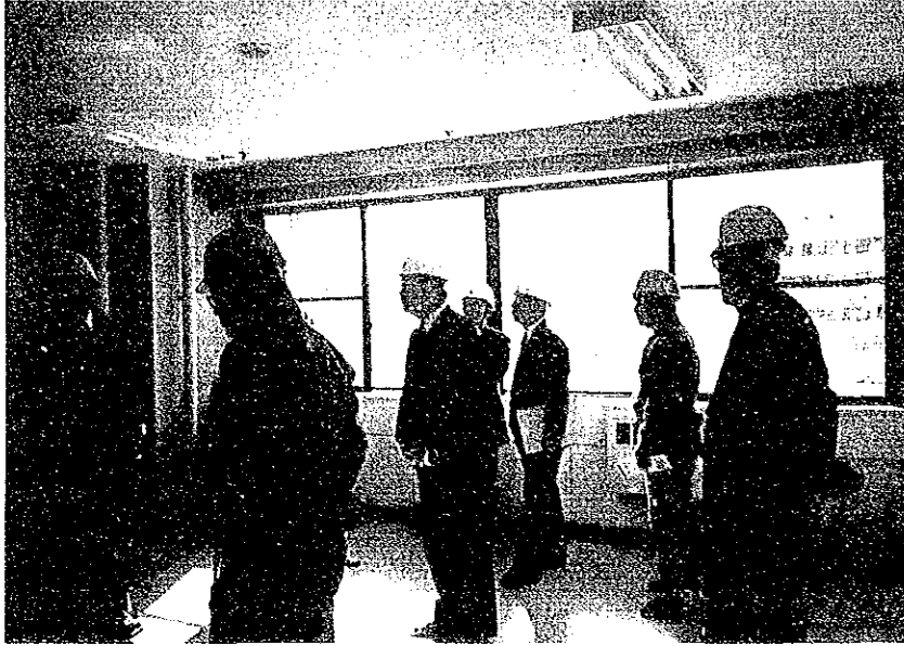
▲ センター工事状況視察 ①
