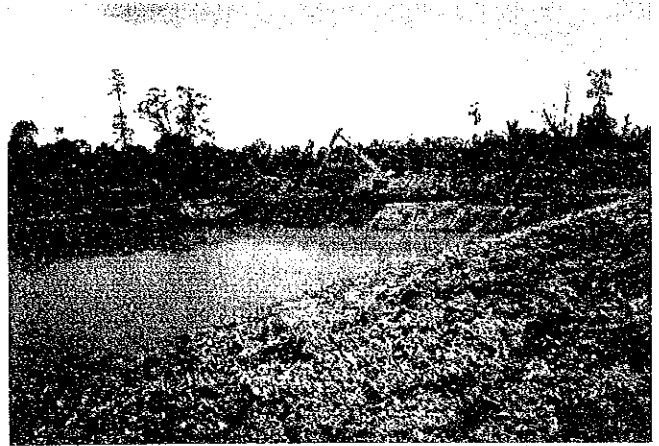
▲ 農業省地方食用作物部による灌漑貯水池の築造。バックフオーによる掘削作業。100×100×15mの大きさで土壌は粘土分が多い。(マリアイ付近)
