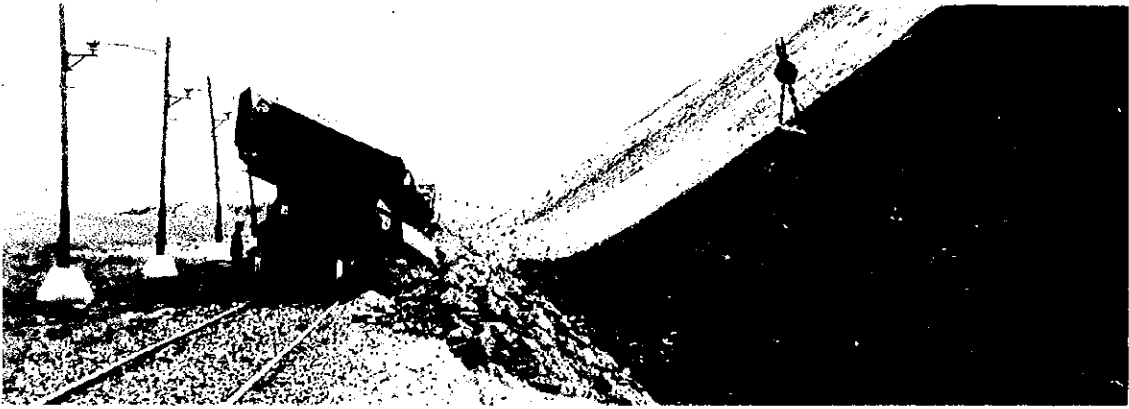
捨土場での剥土ダンピング
