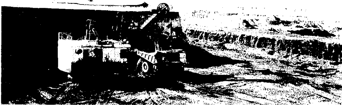
ショベル/トラックシステムによる剥土作業
