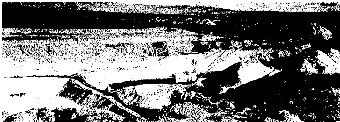
ドラッグラインによる剥土作業
