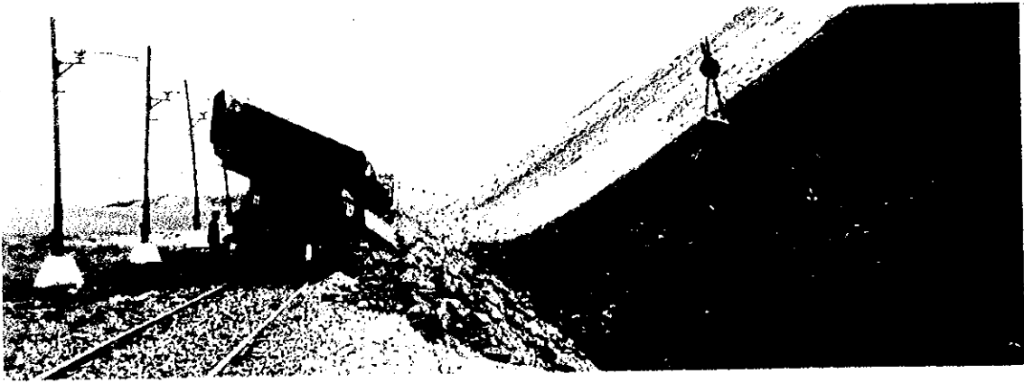
捨土場での剥土ダンピング
