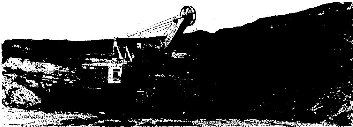
ショベル/トラックシステムによる剥土作業
