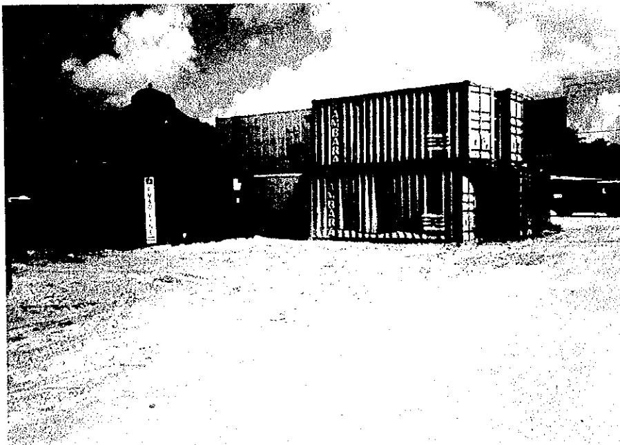
計画予定地（ウエノ商港内） 一時的にコンテナ置場となってい る
