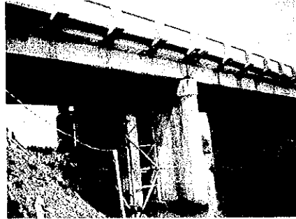
Liboganon 橋。橋脚が沈下。
