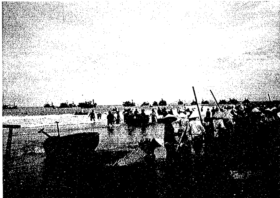
写真-13 ヴンタオ近郊の漁村の水揚げ風景（ロンハイ"LONG HAI"） 栈橋、護岸施設等は一切無く、写真の様な丸形竹製カヌーで沖合いの漁船と浜辺を往復している。
