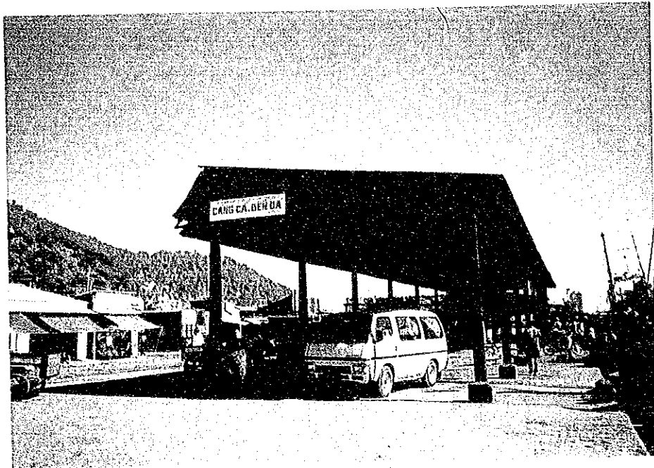
写真-10 ヴンタオ近郊の既存漁港（"BEN DA"ベンダ） 水揚げ桟橋、荷捌き場はあるが、漁船勢力から較べると圧倒的に不足している。 この施設の付近には零細なワークショップ、給油施設がある。
