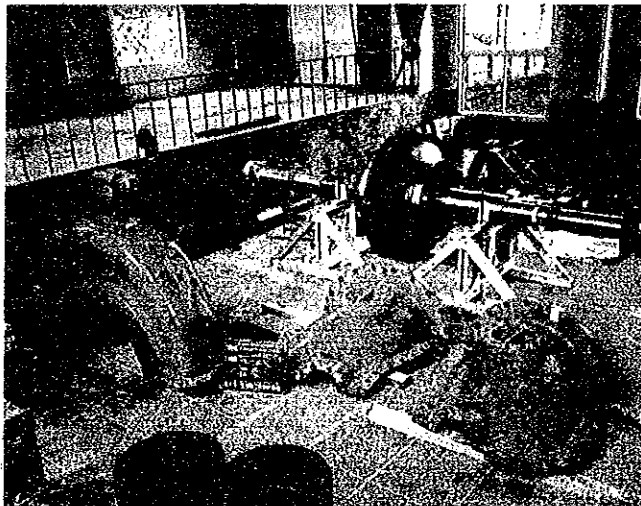
第1揚水機場のポンプシャフトに亀裂が発生していることが、点検調査により発見され早急な交換工事を行った。
