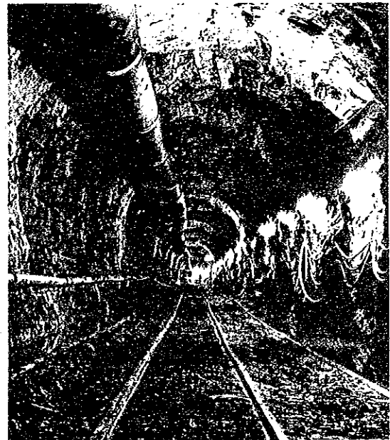
挖掘筑波隧道
