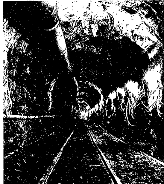
筑波トンネル掘削
