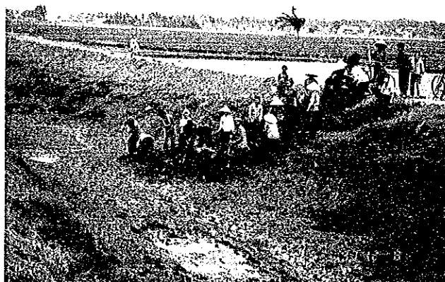
水路の維持管理（推積土砂の撤去）
