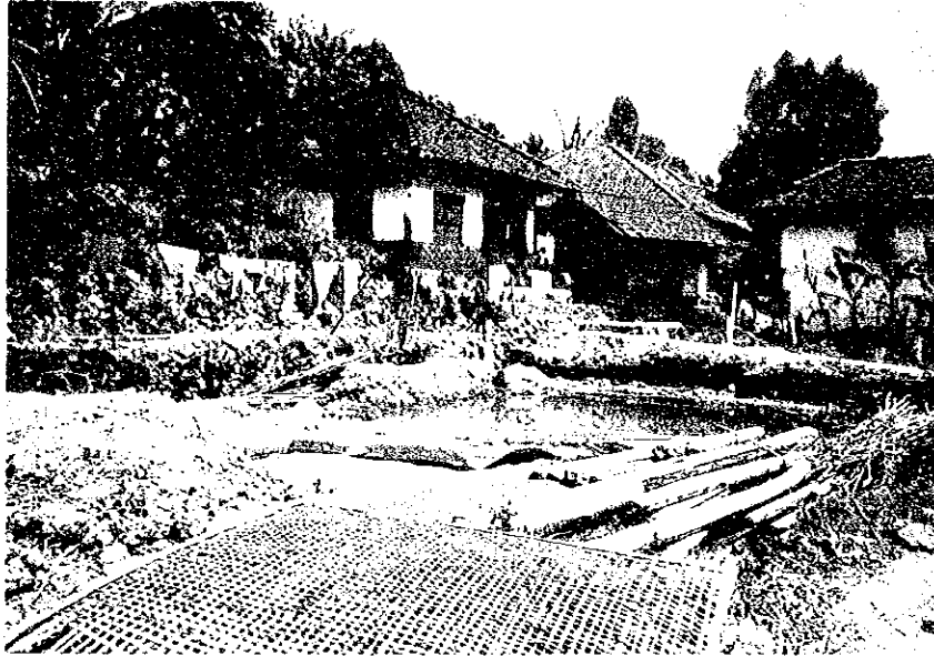
地すべりの一要因と考えられる各家に設けられたため池
