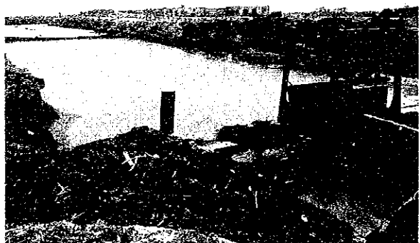
エルハリス地区 93/09/15 エルハリス排水路 (エルハリスポンプ場から上流を見る。) 漂着したゴミが周辺に散乱している。
