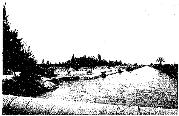
西ヌバリア新規開拓地 ナセル用水路 コンクリート装工されている。
