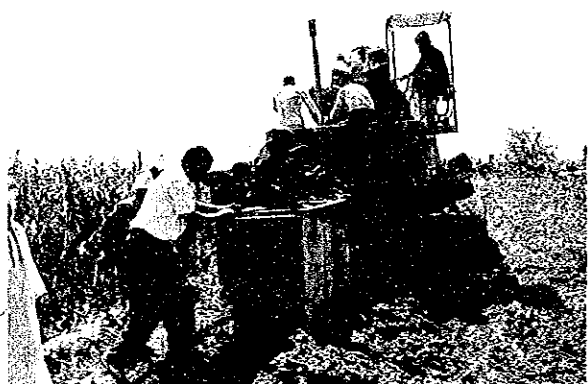
同上 93/09/16 (後面) 架台の上の集水管は少女の乗っているボックス の中で定置される。
