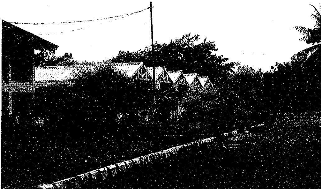
▲JICAプロジェクト基盤整備費で建設したハッチェリー
