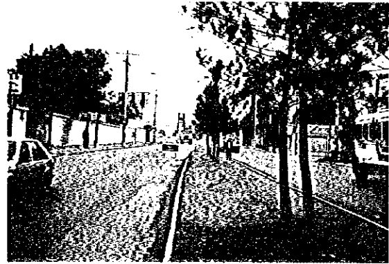
ペタパ道路改良済区間の一部
