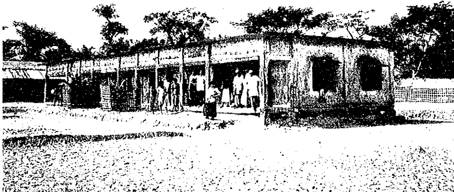
サイトⅡ-1の小学校 〔細体の劣化が激しく〕 施設として使用する に危険な状況
