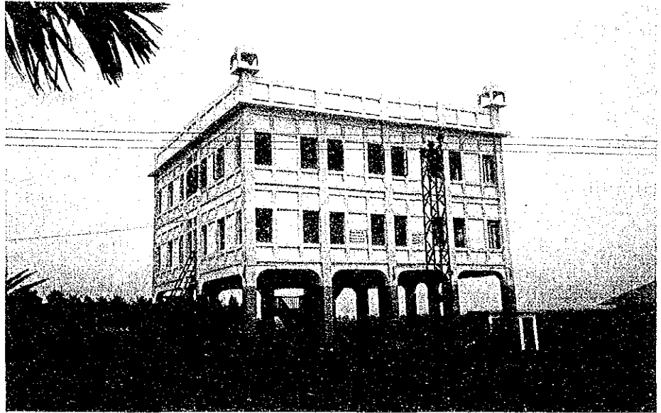
FDにより建設された シェルター
