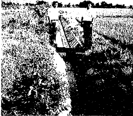
▲ 受益者（農民）負担でコンクリート張りされた末端水路
