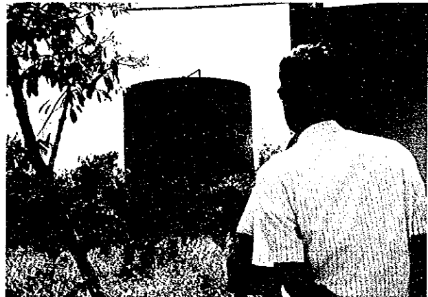
▲ Mendez WD の井戸ポンプ小屋と貯水槽。(11月5日)
