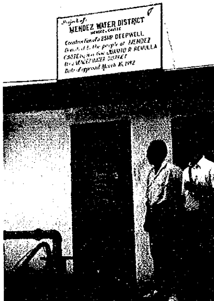
▲ Mendez WD の井戸ポンプ小屋と貯水槽。(11月5日)
