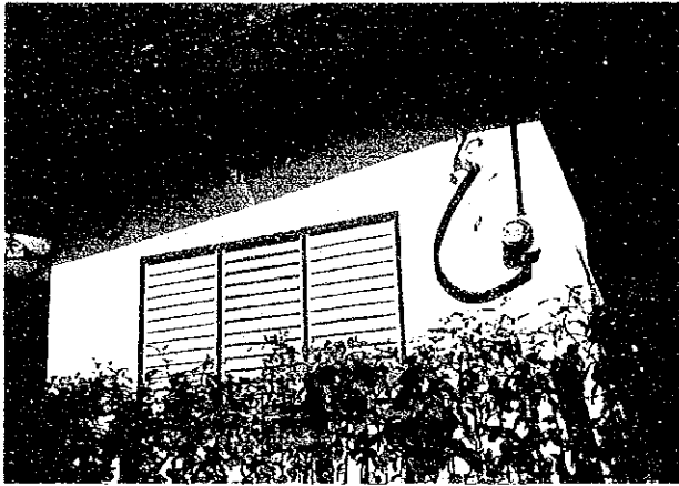
▲ Amadeo の RWSA の 1 つ Iowa Brgy System のポンプ小屋。(11月13日)
