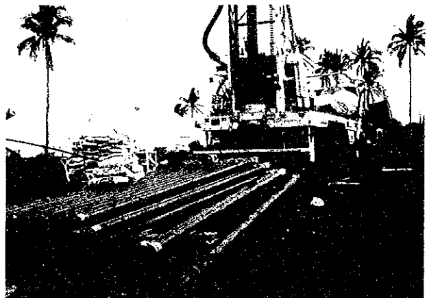
▲ Silang で井戸掘削中の LWUA のドリル・リグ (米国製ロータリーテーブル型リグ)。
