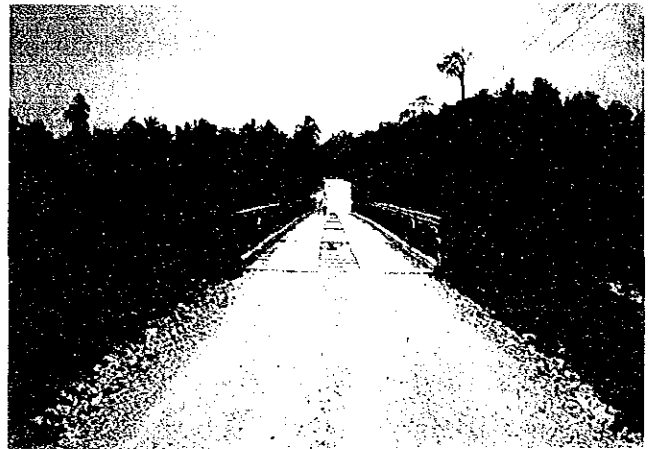
橋梁位置 : Km. 1381+655 Davao Oriental-Surigao del Sur, Coastal Road Andanan Lianga, Surigao del Sur
