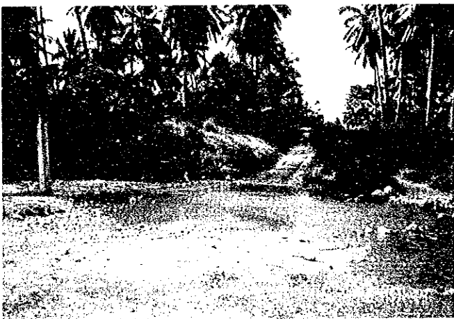
橋梁現況 : 河床渡河 優先度 : B
