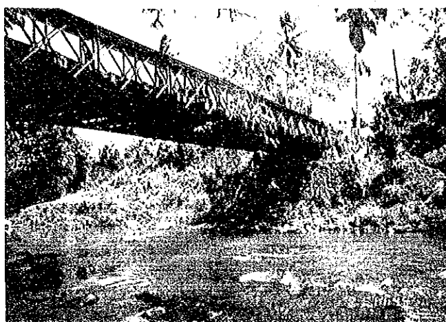
橋梁番号 : 11-05-02 橋梁名 : Los Amigos橋
