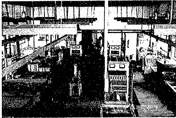
IDB めっき工場の全景
