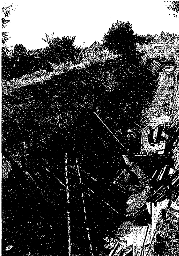
写真3. 建設中のインターセプター。この中に3.5×3.5 mの矩形の管を埋設する。
