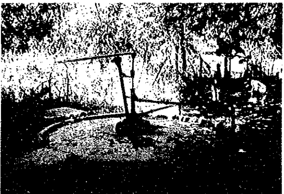
手動ポンプ（1985年据付）
