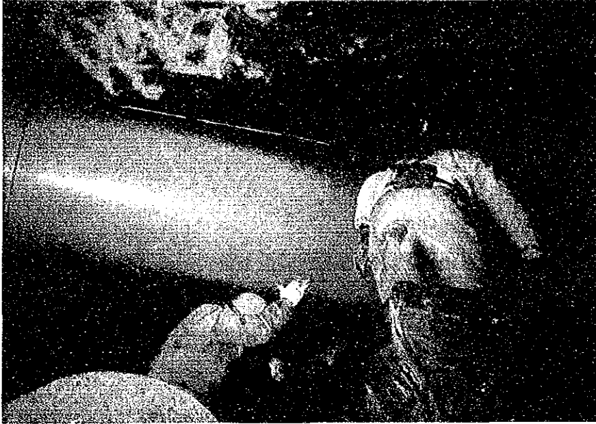
FRV風管設置作業
