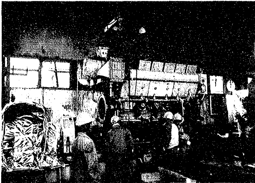
発電機750KVA設置
