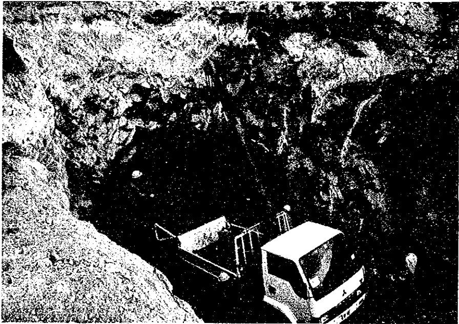
坑門工事（坑樁組立）
