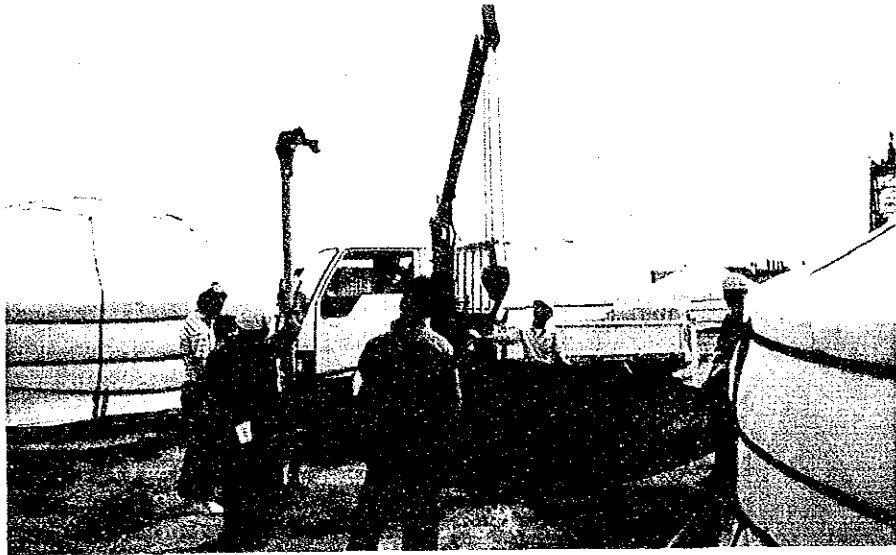
TVアンテナ設置
