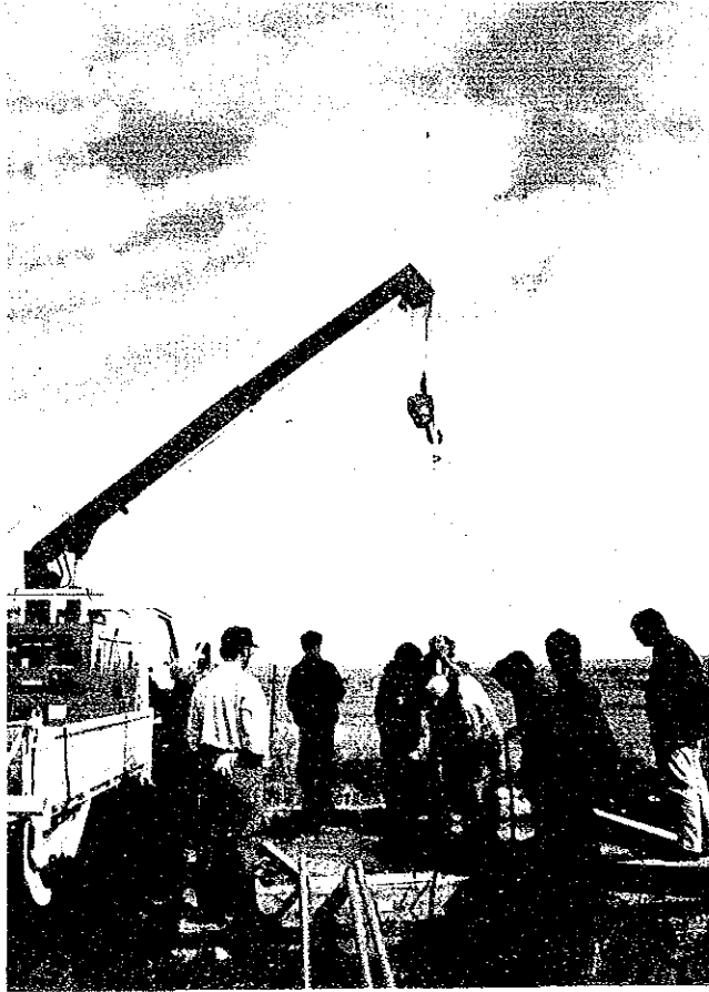
深井戸ポンプ設置
