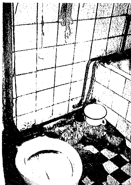
▲ ヌクス市 集合住宅の配管、給湯用配管もある。
