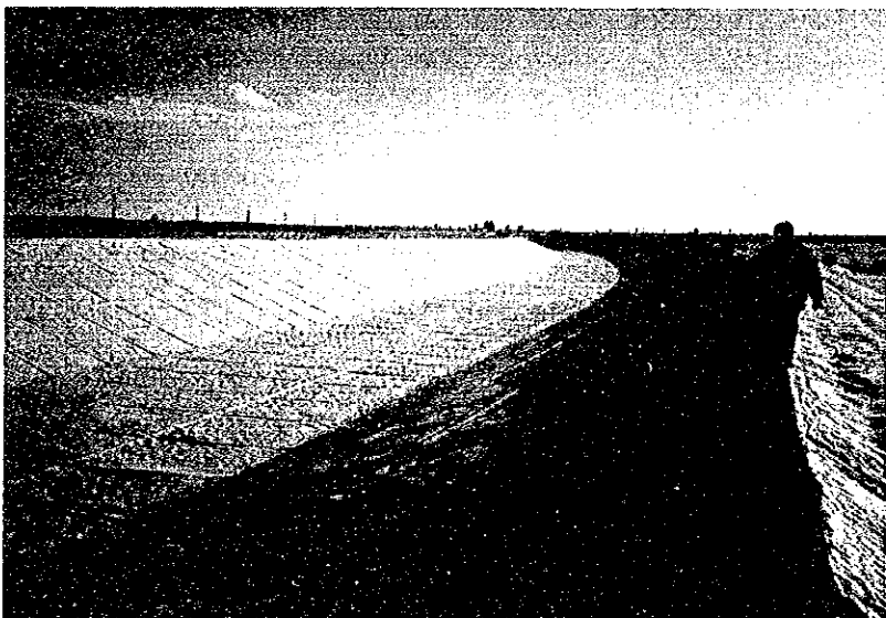
コンクリート三面張 りの幹線水路
